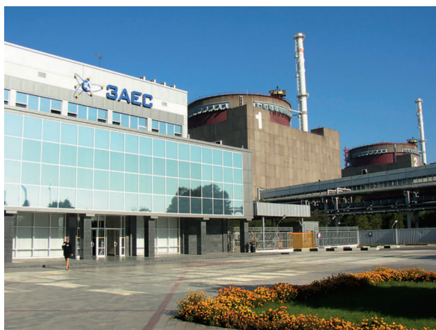
Запорізька АЕС, м. Енергодор
